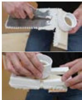
Sélectionnez l'adaptateur du raccord en ABS ou en PVC correspondant au matériau de la conduite d'évacuation et rattachez-le à la bride au moyen d'une pâte ou d'un ruban à sceller.
