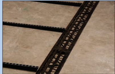
Handi-Kirb™ thin bed rough-in Colocación preliminar del Handi-Kirb™ delgado
