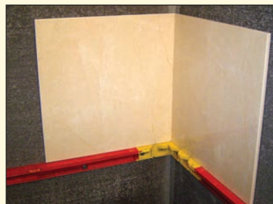
Coloque las baldosas encima del StringA-Level™
