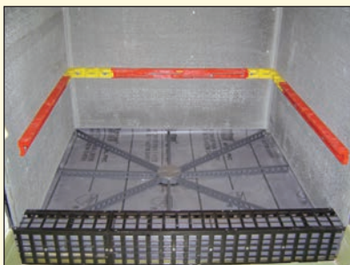
Asegure las secciones del StringA-Level™ a la pared
